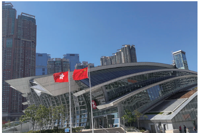
始発駅である西九龍駅の真新しい新駅舎
