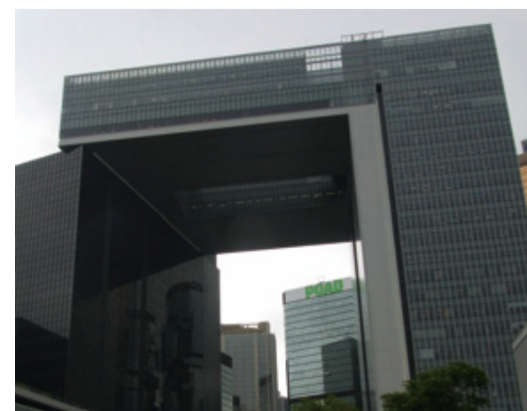
香港政府総合庁舎本部ビル
